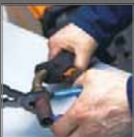
eliminación de la boquilla y su instalación
